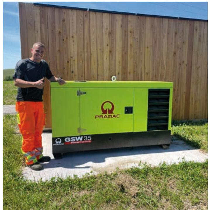
Das neue Notstromaggregat bei der Leitungszentrale wurde Ende Mai von der Fa. Elektro Pühringer installiert. Dieses soll bei Stromausfällen für den Notbetrieb der Wasserversorgung sowie der LWL-Leitung (Glasfaser) dienen.
